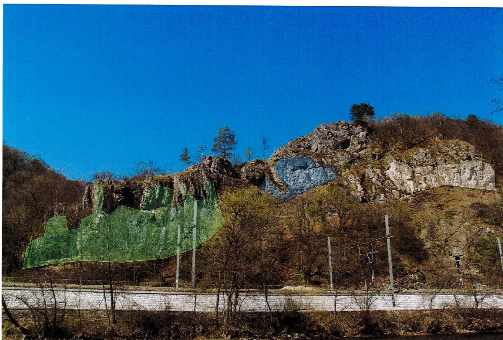
● Rocher principal ● Rocher de la Croix ● Mont-Bell
