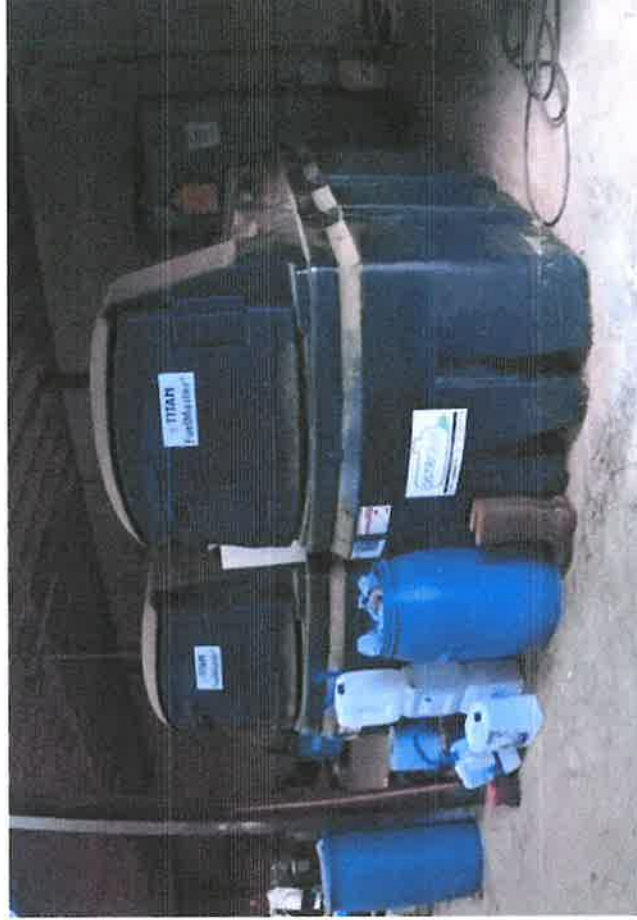
Double citerne aux normes à l'intérieur du bâtiment
