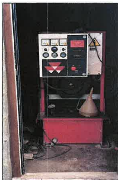
photo 24 : groupe électrogène de secours
